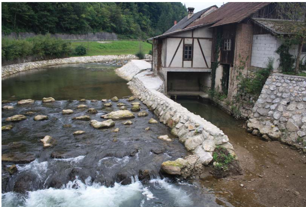
Drče na Mirni: napačna povezava s spodnjo vodo
